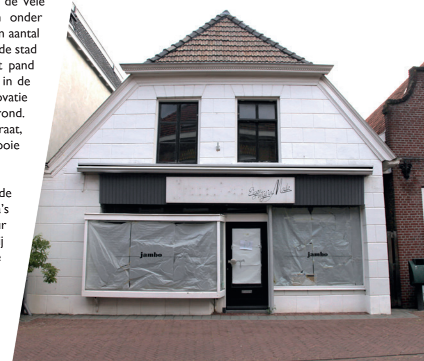
De gevel van het pand voor de renovatie
